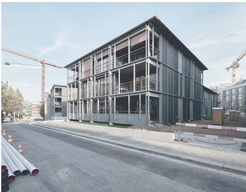
Ein vorgehängter Schleier aus filigranen, vertikalen Holzleisten in der Ebene der Brüstung erinnert an die zwischen Zierwerk und Tragstruktur oszillierenden Stahl- und Glasfassaden vieler Bürobauten der Nachkriegsmoderne und bildet eine Filterschicht für die zur Strasse orientierten Schlafzimmer und Loggien.
